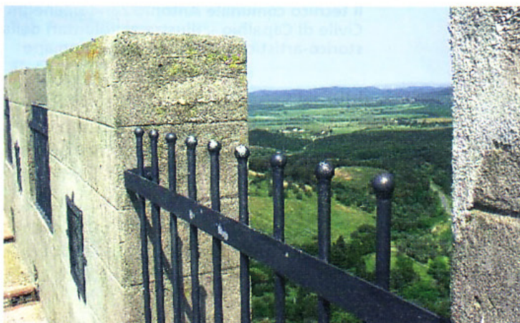
Bastioni merlati del secondo cammino di ronda del castello di Capalbio
