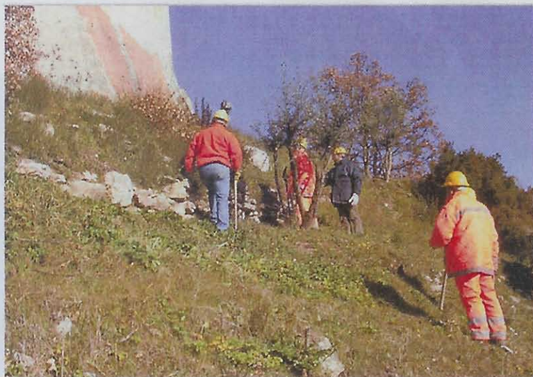
Intervento di messa in sicurezza della rupe della Rocca a Tentennano
