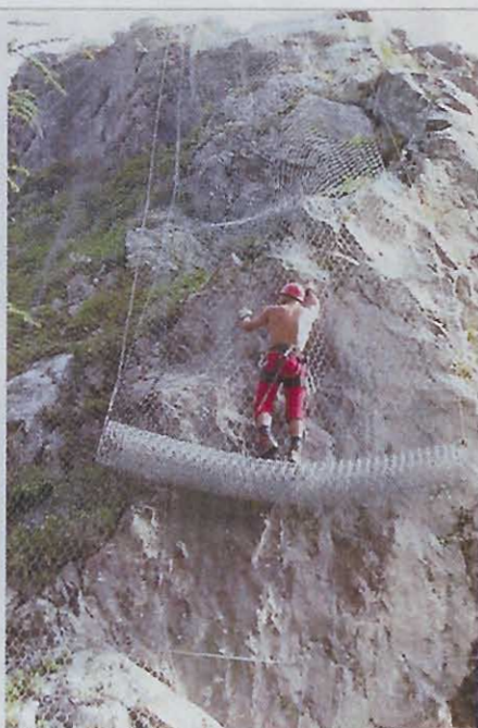
Alcune fasi della messa in sicurezza della rupe a ridosso del nucleo abitato di Castiglione D'Orcia
